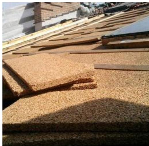
Figure 2 – Painéis utilizados para isolar e cobrir a película
