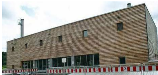
Nová energetická stanice v Liebenau
