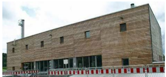
Die neue Energiezentrale in Liebenau
