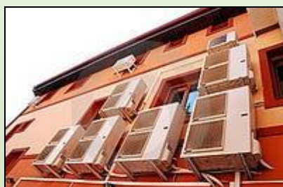
Sistema de aire acondicionado descentralizado (Italia) and ventanas abiertas en temporada de calefacción (Eslovenia)
